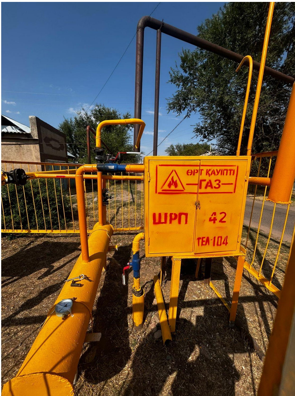
Жамбылская область, Меркенский район, село Мерке ул. Кемелбекова, ШРП №42 (ШРП с регулятором давления газа РДНК-1000)
