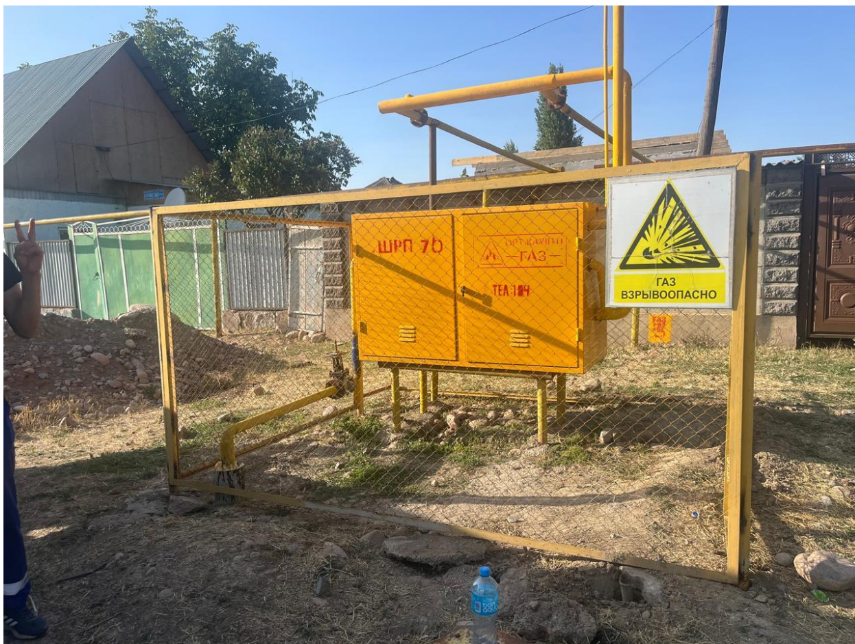
Жамбылская область, Меркенский район, село Акарал ул. Сейтимбет, ШРП №70 (ШРП с регулятором давления газа РДГ-50)
