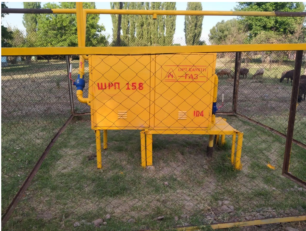
Жамбылская область, Меркенский район, село Андас Батыр ул. Жамбыла, ШРП №158 (ШРП с регулятором давления газа РДГ-50)
