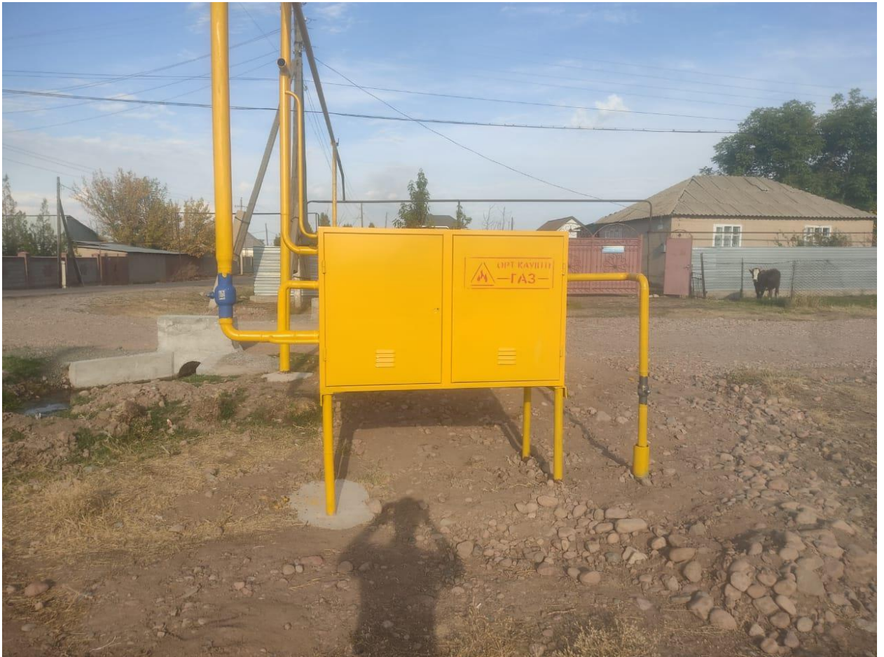
Жамбылская область, Меркенский район, село Плодоягодное ул. Киргизбаева, ШРП №149 (ШРП с регулятором давления газа РДГ-50)
