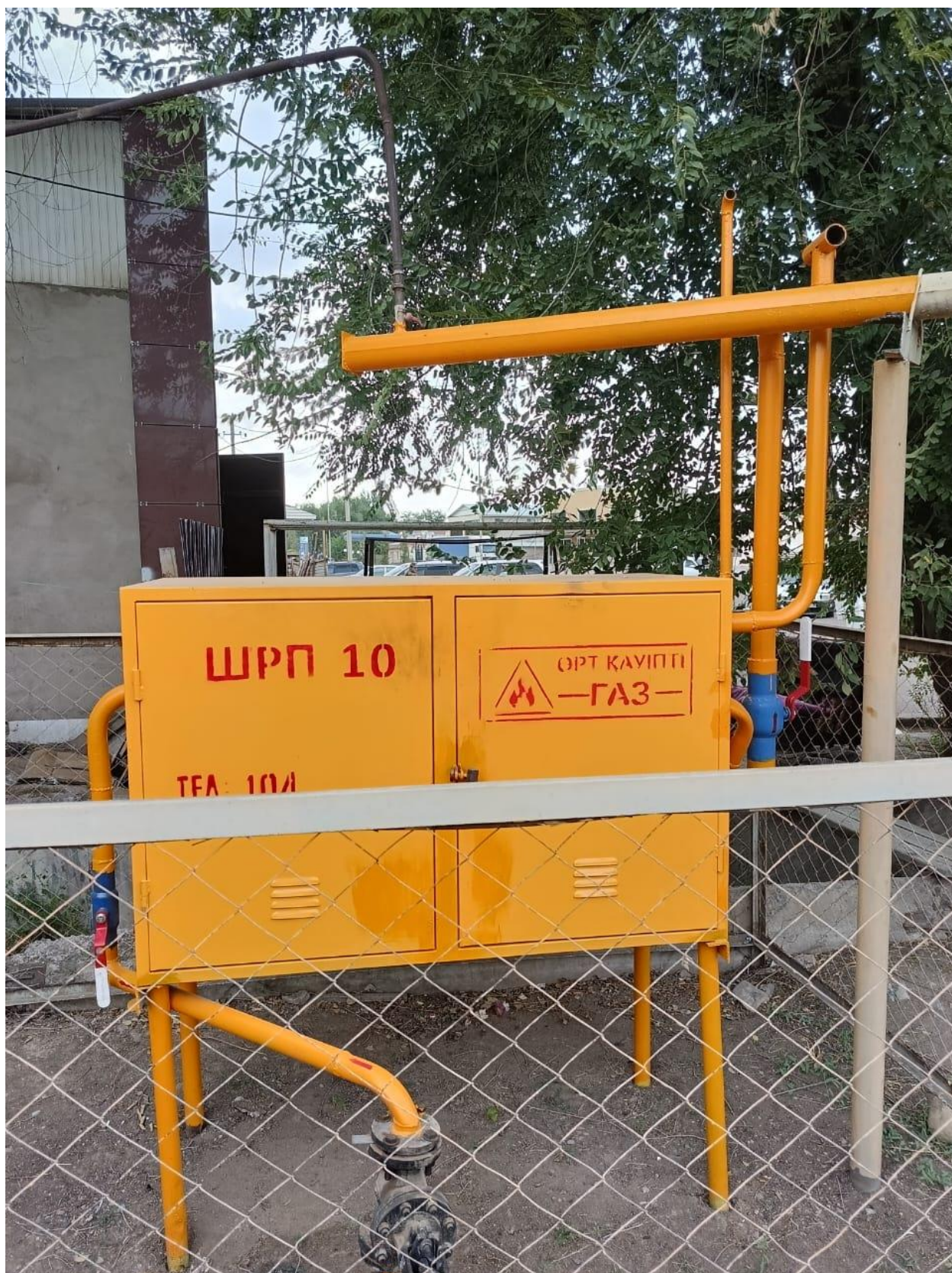
Жамбылская область, Меркенский район, село Сарымолдаево ул. Мажиева, ШРП №10 (ШРП с регулятором давления газа РДГ-50)
